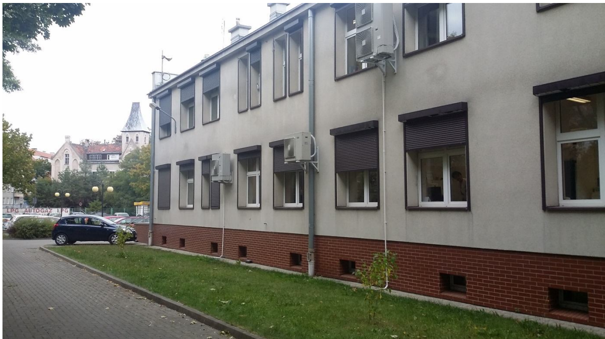
Widoki budynek przeznaczony do rozbudowy od strony ul. Henryka Sienkiewicza
